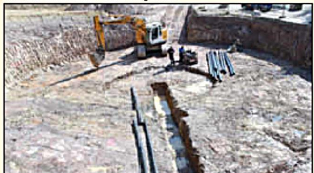
.....Leerrohre werden verlegt
