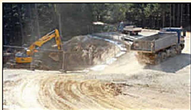
.....die Erdarbeiten haben begonnen
