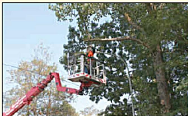
.....die vorbereitenden Arbeiten an der Zuwegung zu den Windkraftanlagen
